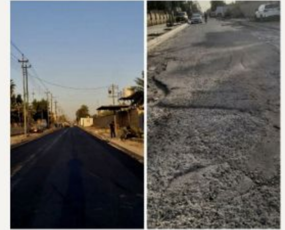
شبكة الصرف الصحي في حي الحكيم
